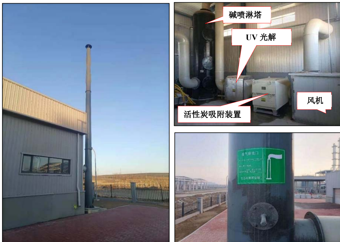
污水处理站废气处理设施、排气筒（DA003）及其图形标志牌
