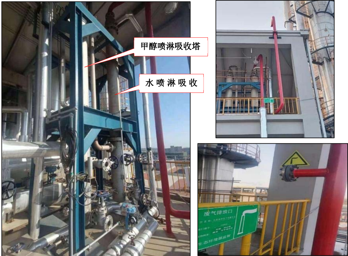
2,6-二甲酚不凝气处理装置、排气筒（DA001）及其图形标志牌
