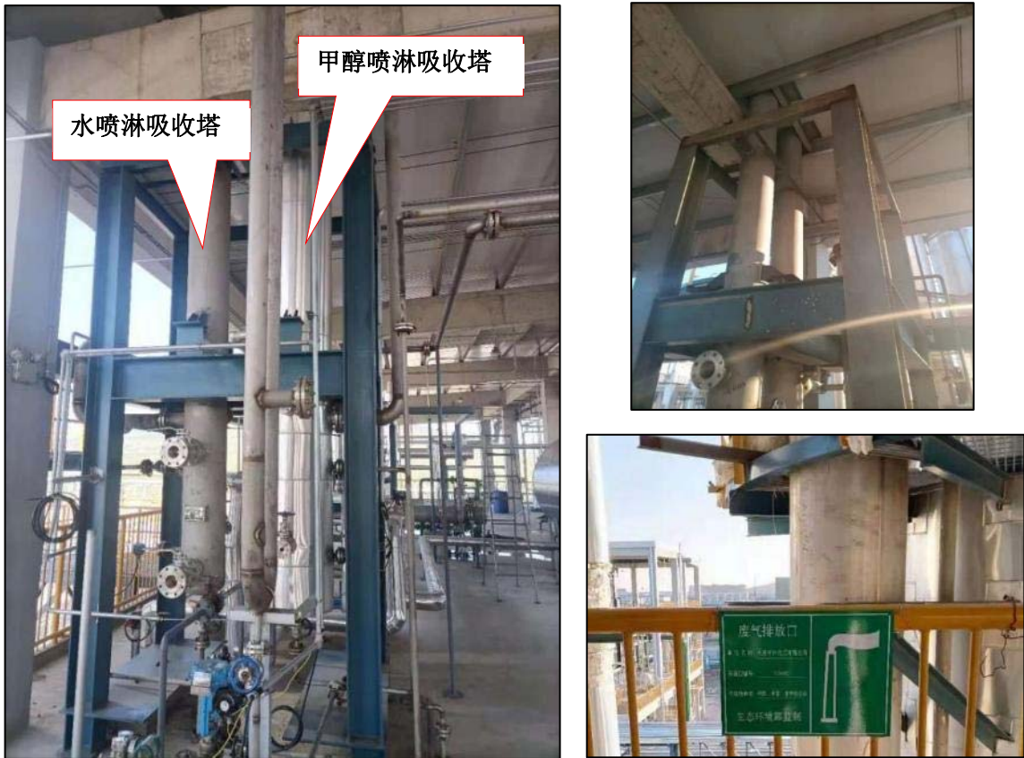
聚芳醚不凝气处理装置、排气筒（DA002）及其图形标志牌
