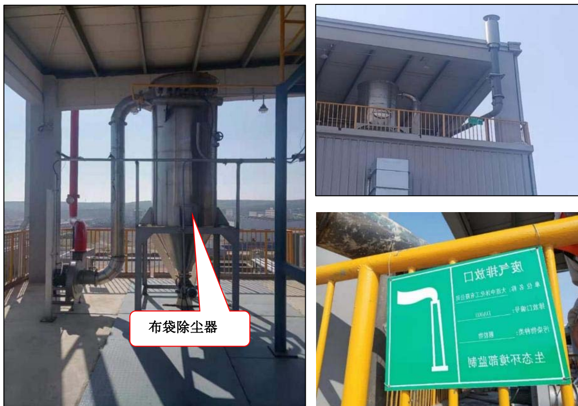
聚芳醚分装粉尘处理装置、排气筒（DA005）及其图像标志牌
