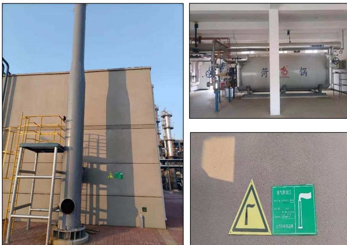
导热油炉、烟气排气筒（DA006）及其图形标志牌
